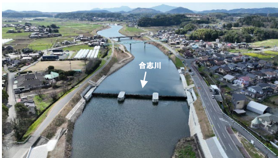
完成した山城堰（合志川）
